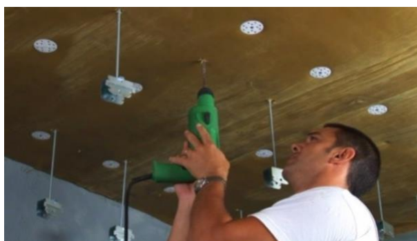
Fixation du Tecsound 2FT en plafond
