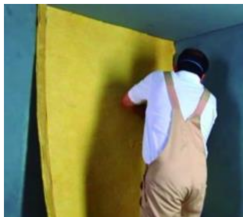
Utilisation du Tecsound 2FT en paroi verticale
