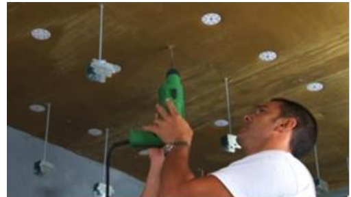
Fixation mécanique au plafond
