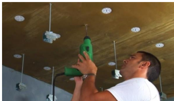
Utilisation de la fixation PT-H 70
