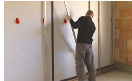
**F** Mettre en place la fourrure par clipsage sur **Efi Clic**.
