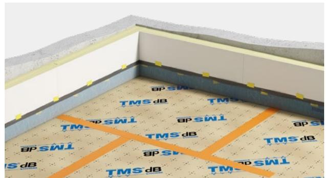
**D** Les panneaux **TMS® dB** sont posés jointifs et pontés avec l'ajout d'une bande adhésive complémentaire.
