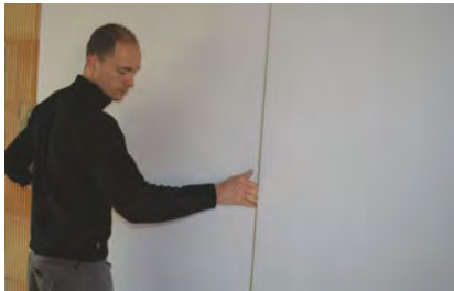
A Poser l'isolant EFIMUR® .
