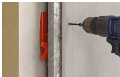
H Poser les plaques de plâtre.
