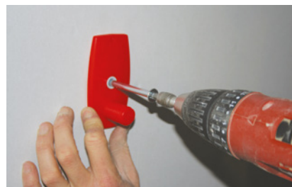
C Percer Efi Clic sur le panneau EFIMUR® .
