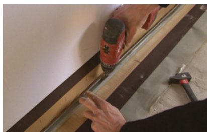
E Fixer mécaniquement les lisses hautes et basses
