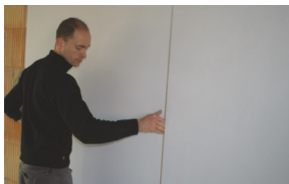
A Poser l'isolant EFIMUR® .
