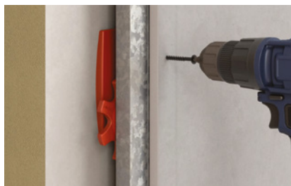
H Poser les plaques de plâtre.
