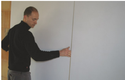
A Poser l'isolant EFIMUR® .
