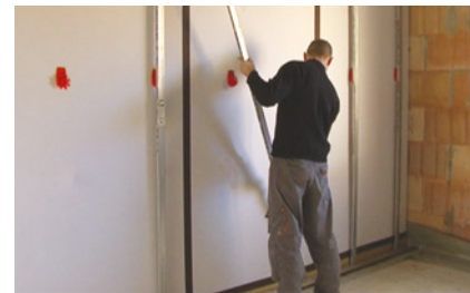
F Mettre en place la fourrure par clipsage sur Efi Clic .
