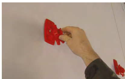
D Assembler l'appui Efi Clic .
