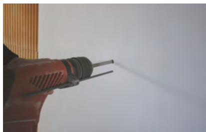
B Tracer et percer l'emplacement de l' Efi Clic .
