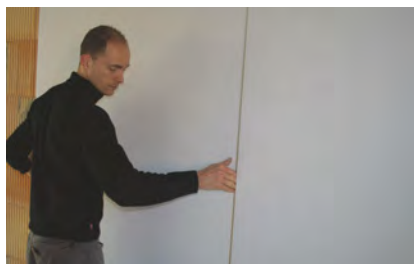
A Poser l'isolant EFIMUR® .
