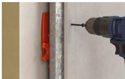
H Poser les plaques de plâtre.
