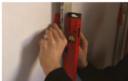
G Régler la planéité de la fourrure après mise en œuvre de l'isolant thermo-acoustique optionnel.
