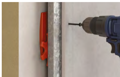
H Poser les plaques de plâtre.
